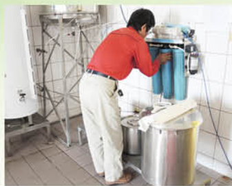
▲ 1060214 廚房定期濾水器濾心更換
