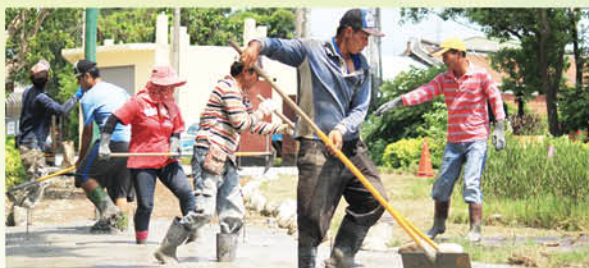
▲ 1060706 北側入學道路施工
