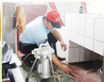
▲ 1060615 水管阻塞疏通
