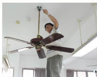
▲ 1061020 六甲吊扇修繕
