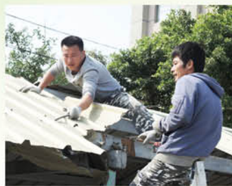
▲ 1060218 車棚屋頂維修
