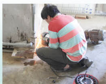
▲ 1061126 廚房濾煙設備馬達修繕
