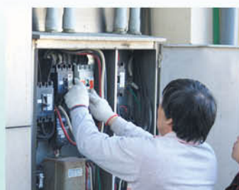
▲ 1070102 北棟教室變電器更換
